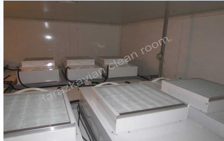
سیستم فن فیلتر یونیت شرکت زلاتین کیسول طراحی ، تولید و اجرا شرکت فراز کاویان
