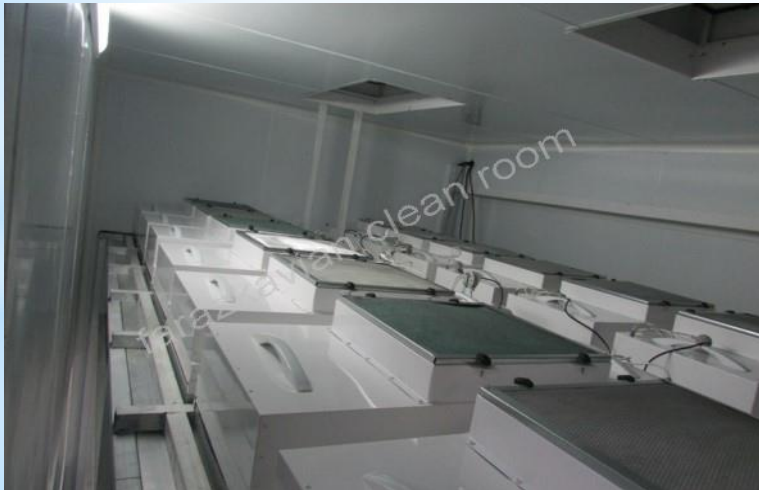
سیستم فن فیلتر یونیت شرکت دکتر عبیدی (آرایشی بهداشتی) طراحی ، تولید و اجرا شرکت فراز کاویان
