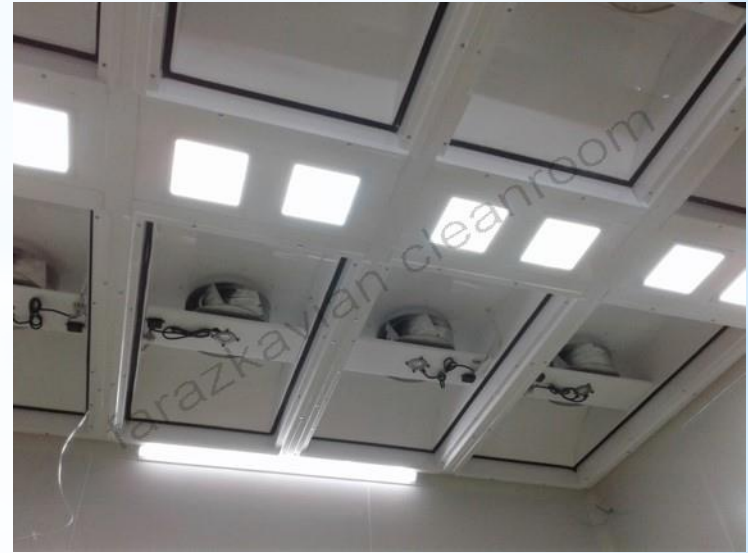
سیستم فن فیلتر یونیت بانک چشم ایران طراحی ، تولید و اجرا شرکت فراز کاویان
