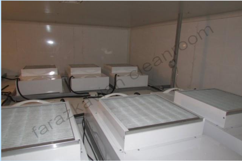
سیستم فن فیلتر یونیت شرکت ژلاتین کپسول طراحی ، تولید و اجرا شرکت فراز کاویان
